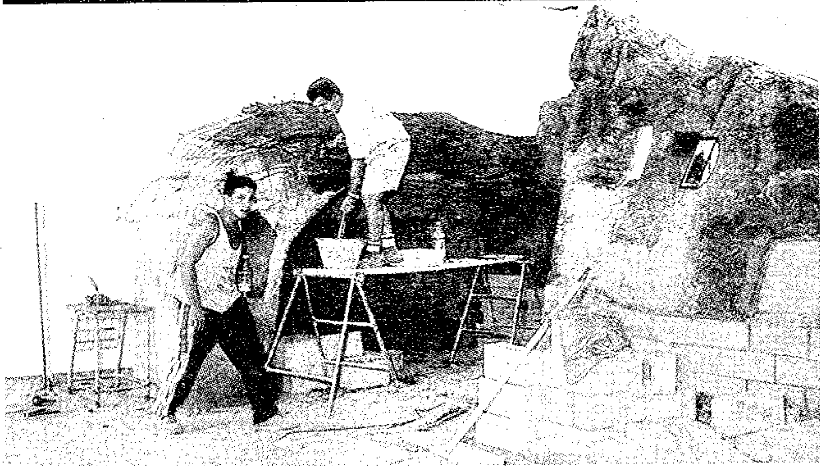
Trabajos de albañilería - Local Central
