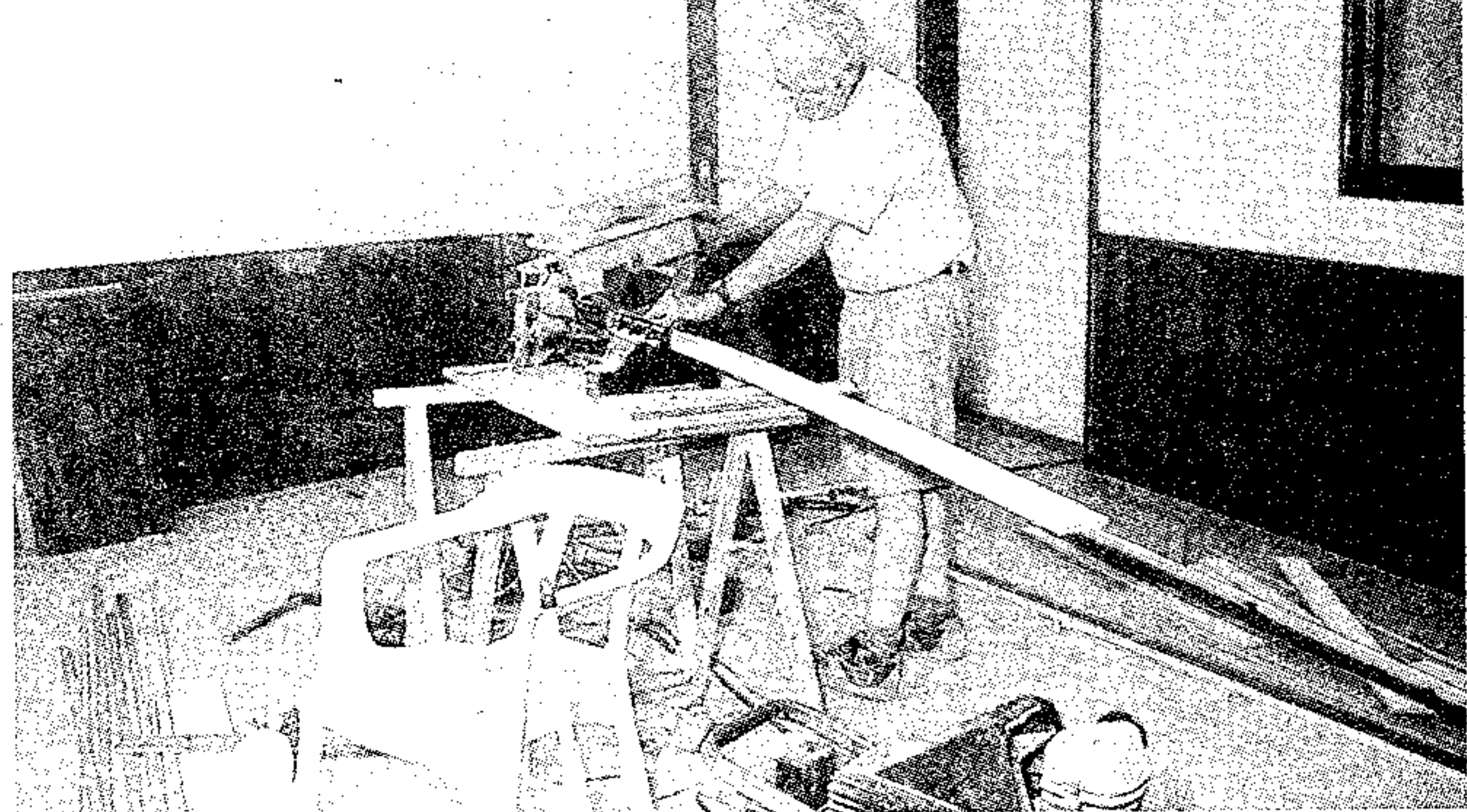
Trabajos de carpintería - Aula de Formación
